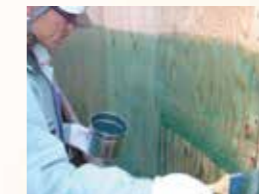
ホウ酸処理作業風景 ※着色剤使用例
